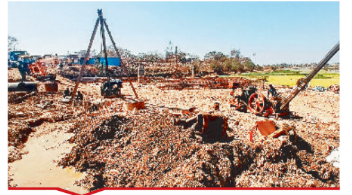
शनिचरी रपटा पर पुल निर्माण का कार्य प्रगति पर है।
